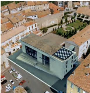
Toiture photovoltaïque en damier sur la MJC de Narbonne - architecte : atelier 2Ai - Yvan Tognella architecte.
